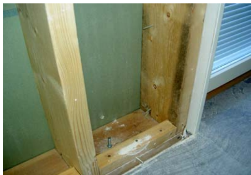
Bild 23. Angripen träregel i nyproduktion
